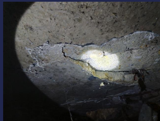
Fot. 14 - 15 Rozwarstwienie płyty betonowej nad I kondygnacją
