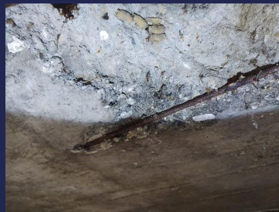
Fot. 16-17 Korozja, rozwarstwienie płyty betonowej nad I kondygnacją
