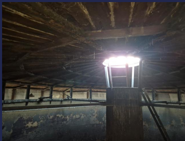
Fot. 20 Zdjęcie wnętrza zbiornika.
