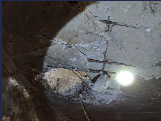
Fot. 14 - 15 Rozwarstwienie płyty betonowej nad I kondygnacją
