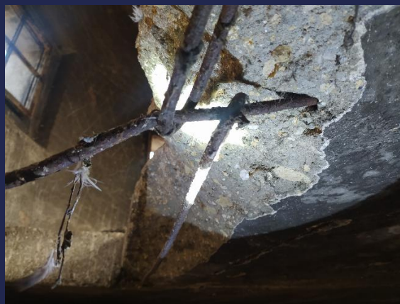
Fot. 16-17 Korozja, rozwarstwienie płyty betonowej nad I kondygnacją
